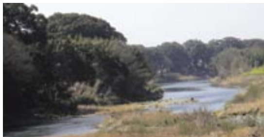
1695年につくられた護岸工事の千間土居
